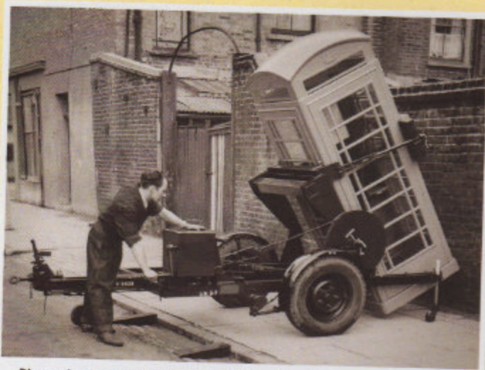
Phone boxes were delivered and installed using a special trailer. Roedd trelar arbennig yn cael ei ddefnyddio i ddanfôn a gosod blychau ffôn.
